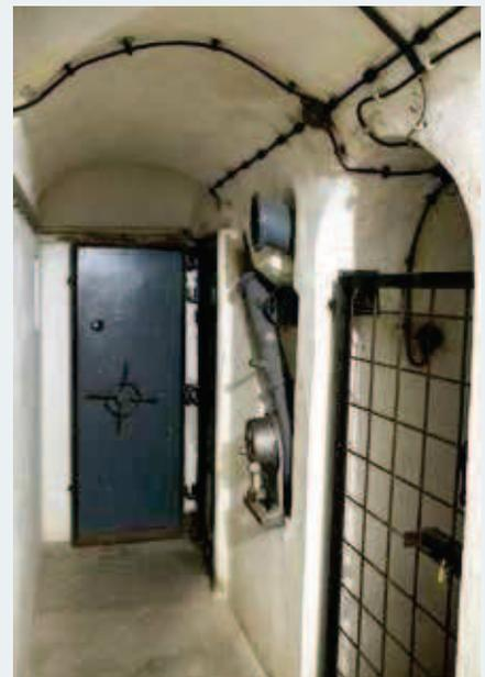
*Im Bild der Zugang zu einem Kampfstand. Gut zu erkennen der Handventilator für die Belüftung des Kampfstandes und die originalen Stromleitungen, die auch heute noch die Räume mit Licht und Strom versorgen.*
