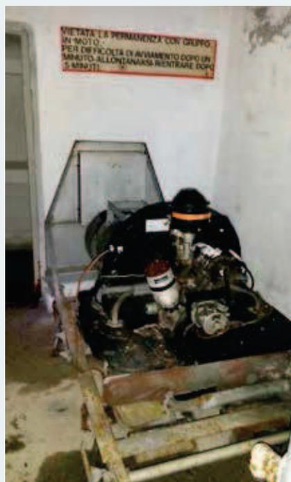
Der Notstromgenerator im Bunker Nr. 9 in Mitterolang (Marer Bunker). Die Leistung des von einem VW Käfer Motor betriebenen Aggregats beträgt 10 kW.
